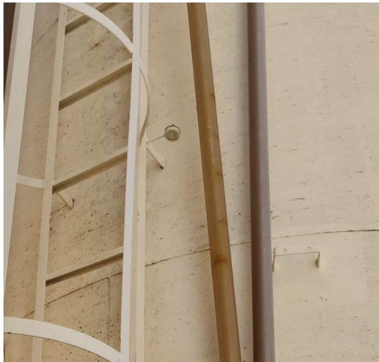
Figura 32 - Olhal de descida de aterramento de cabeamento - Reservatório Mangabeiras
