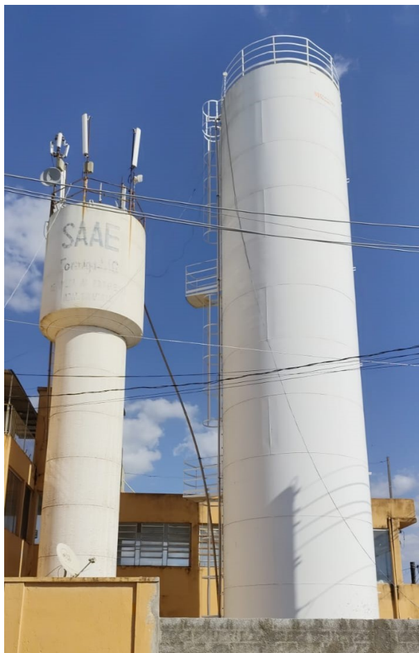
Figura 31 - Reservatório Bairro Mangabeiras
