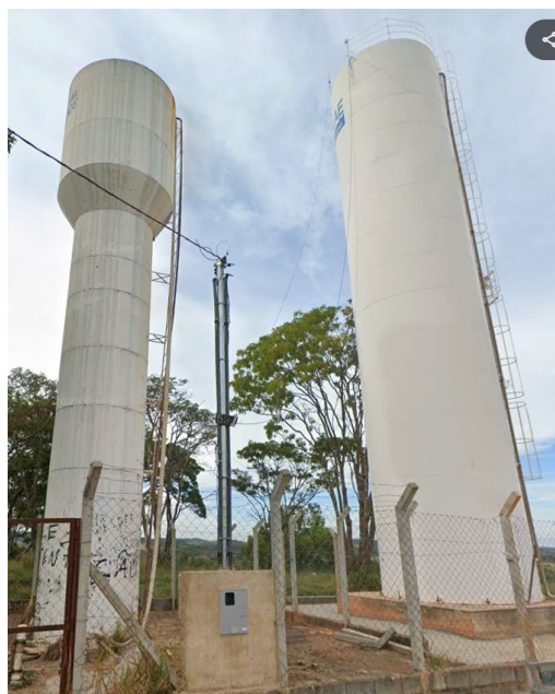
Figura 42 - Reservatório Jardim Morumbi
