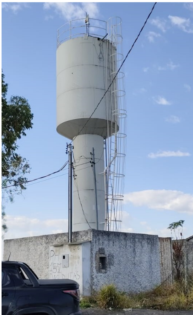
Figura 44 - Reservatório Tino Pereira
