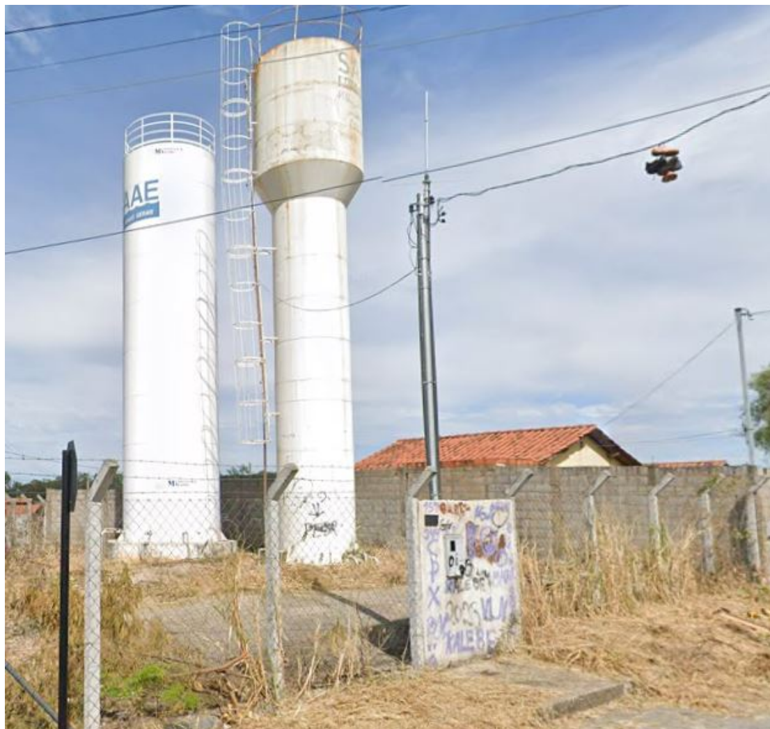
Figura 51 - Reservatório Ércio Rocha
