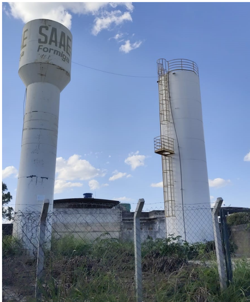
Figura 67 - Reservatório Santo Antônio
