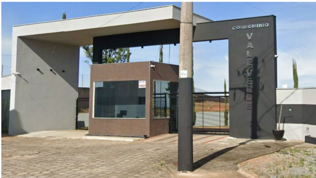
Figura 35 - Condomínio Vale Verde - Localização do Reservatório Novo Horizonte
