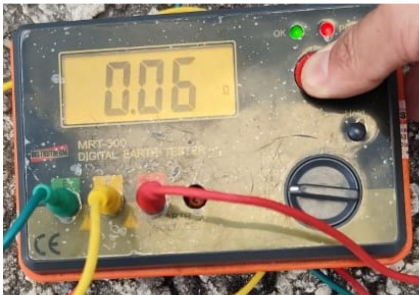
Figura 77 - Medição de resistividade do sistema de SPDA - Reservatório Califórnia
