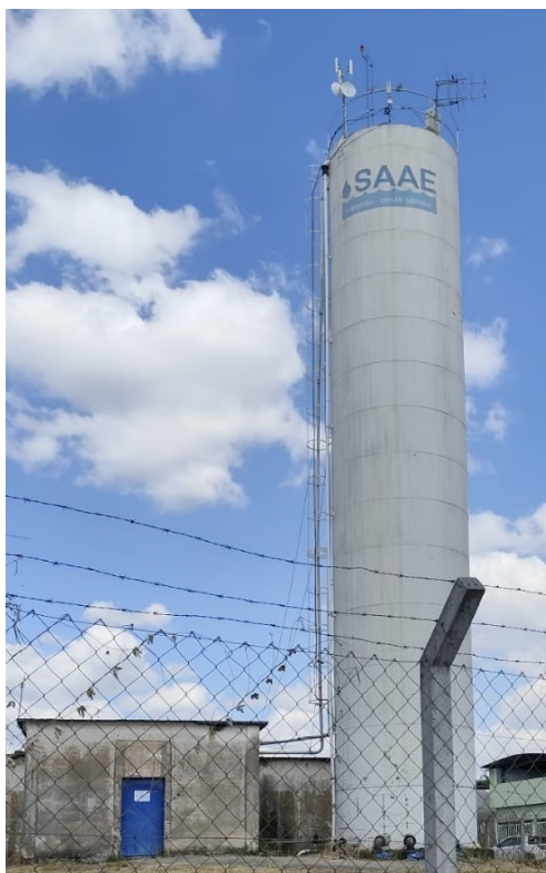
Figura 20 - Reservatório Nossa Senhora de Lourdes
