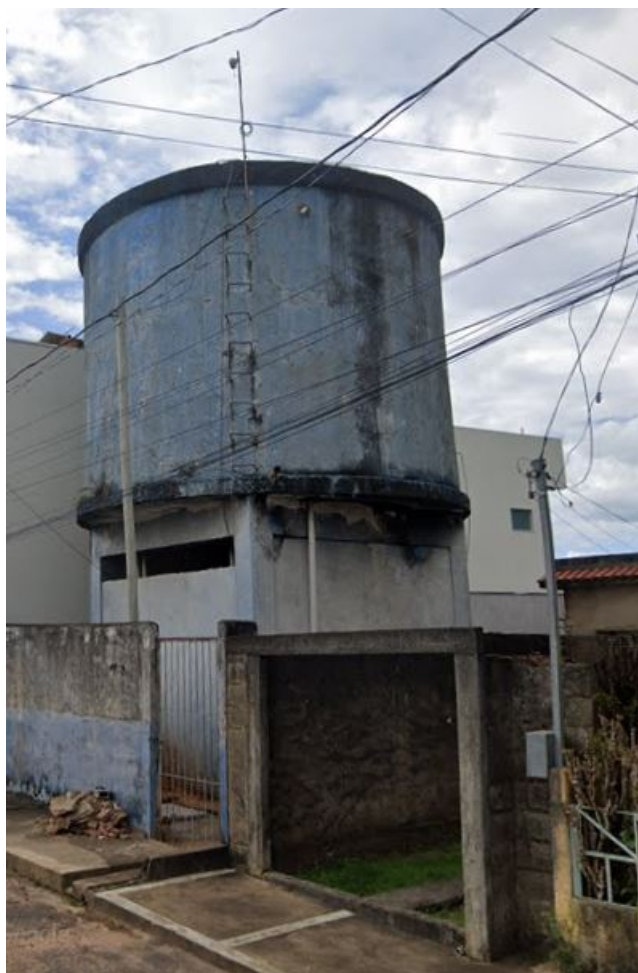
Figura 3 - Reservatório de Água Santa Luzia
