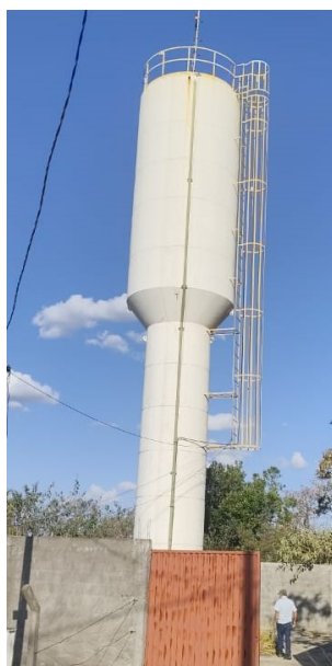
Figura 69 - Reservatório Alto dos Pinheiros I
